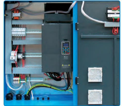
Quadro elettrico e inverter.
