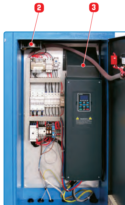
Quadro elettrico e inverter.
